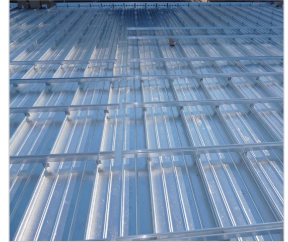
C-Schiene auf Rundfalzklemmen
