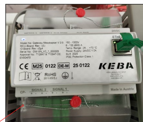
Abb. 34: Versiegelung DC-Messkapsel V2
