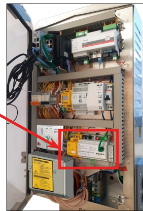
Abb. 36: Einbauposition - DC-Messkapsel V2
