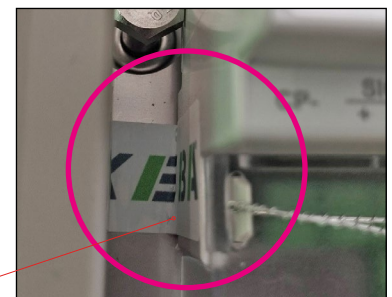
Abb. 33: Versiegelung - DC-Messkapsel V2
