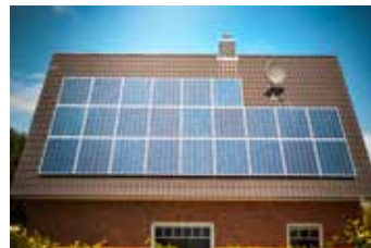
Anlage mit herkömmlichen Modulen
