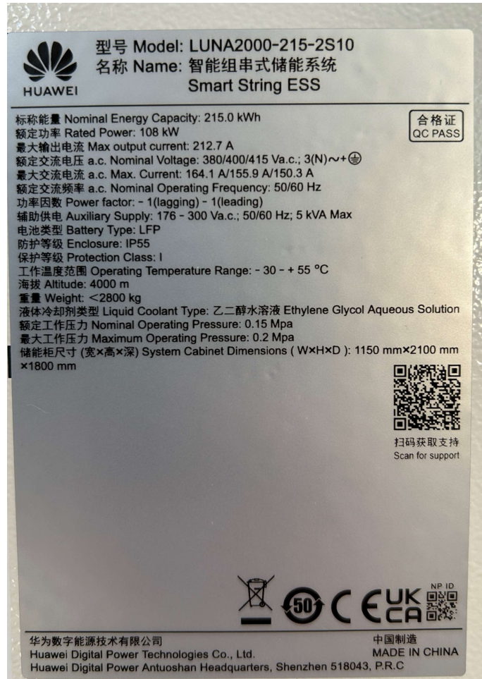
Bild 1: Typenschilder des Energiespeicher LUNA2000-215-2S10
