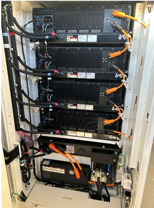
Bild 4: Energiespeicher Typ LUNA2000-215-2S10: Innenansicht
