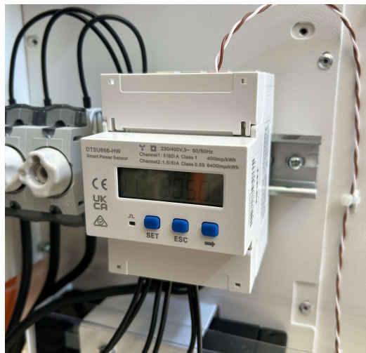
Bild 5: Energiespeicher Typ LUNA2000-215-2S10: Smart Power Sensor
