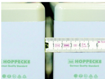
Abb. 5-14: 10 mm Abstand zwischen den Batteriezellen
