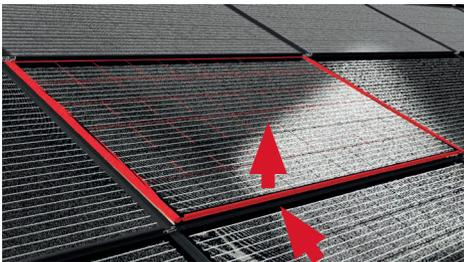
Faites d'abord glisser le panneau à soulever parallèlement à la surface du panneau vers le haut, jusqu'à ce qu'il se détache de l'insertion du bas.
