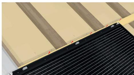
Fixez le panneau à l'aide des vis de fixation dans le lattage du panneau (6 vis par panneau).
