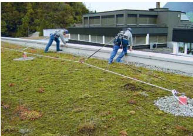
Abb. 10: Temporäres Seilsystem mit Karabinerhaken an EAP befestigt
