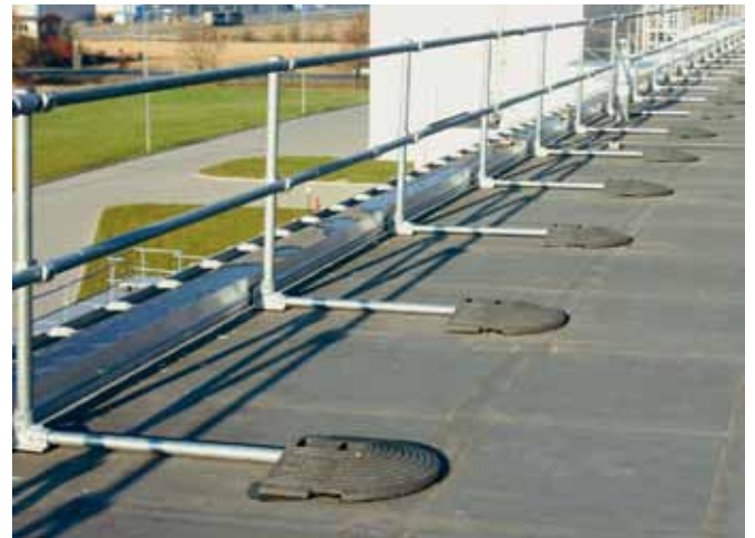
Abb. 16: Ausstattungsstufe 3: Seitenschutzsystem mit Auflast
