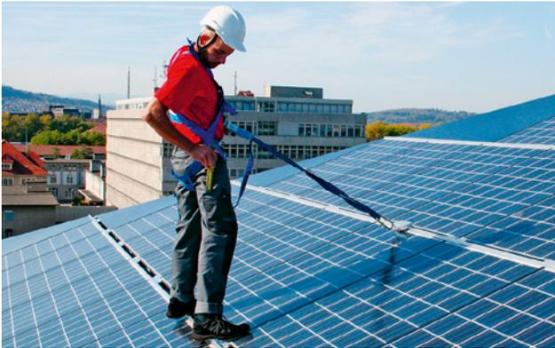
13 Système d'ancrage intégré dans l'installation solaire
