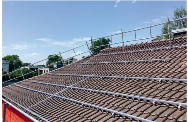
3 Le garde-corps périphérique installé sur le faîte empêche les chutes sur le côté du toit non concerné par les travaux.
