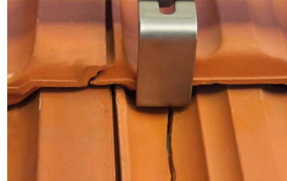
Beim Anbringen des Dachhakens ist es bisher üblich, den Ziegel an der Oberkante so zu bearbeiten, dass der Haken montiert werden kann. Diese Vorgehensweise führt unweigerlich zu Ziegelschaden; feine Risse sind oftmals zunächst nicht sichtbar und führen später zu Ziegelbruch. Führende Dachplattenhersteller wie z. B. CREATON übernehmen keine Gewährleistung auf die Bruchlast und Regen- eintragsicherheit bearbeiteter Tondachziegel und verweisen auf die Vorzüge unserer Metalldachplatten.
