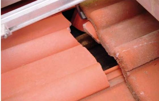
Marzari-Technik hat eine einfache und innovative Lösung, um Ziegelbruch und den nachfolgenden Kosten vorzubeugen. Bei der herkömmlichen Montage werden die Dachziegel ausgeflext, um Platz für die Dachhaken zu schaffen. **Mit den Marzari Metalldachplatten werden die herkömmlichen Ziegel ersetzt und ein Ausflexen ist nicht mehr notwendig.** Die Dachplatte liegt unter dem Dachhaken und lässt sich einfach an die Originaldeckung des Daches anpassen.
