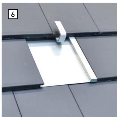
Achten Sie bei der Montage Ihrer Metaldachplatte stets auch auf eine korrekte Montage des Schaumkeils. Eine unsachgemäße Vorbereitung und Anbringung des Schaumkeils kann hinterher zu Problemen führen.
