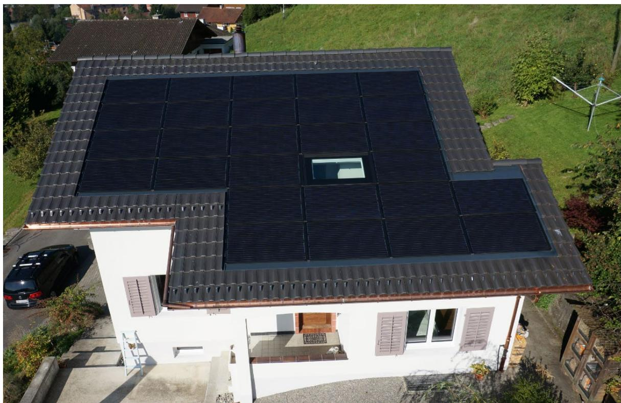
Per l'integrazione dell'impianto Arres in un tetto in tegole esistente si adattano in particolare le lamiera di raccordo standard che possono essere ordinate come optional.
