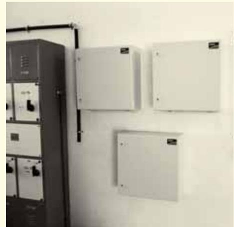
**SCHNITTSTELLE** Der Fuel Save Controller integriert die Photovoltaik in das Dieselnetz. So spart Alpine Knits 50 000 Liter Kraftstoff im Jahr.
