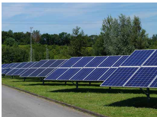
PV-Anlage am Standort Hagen
