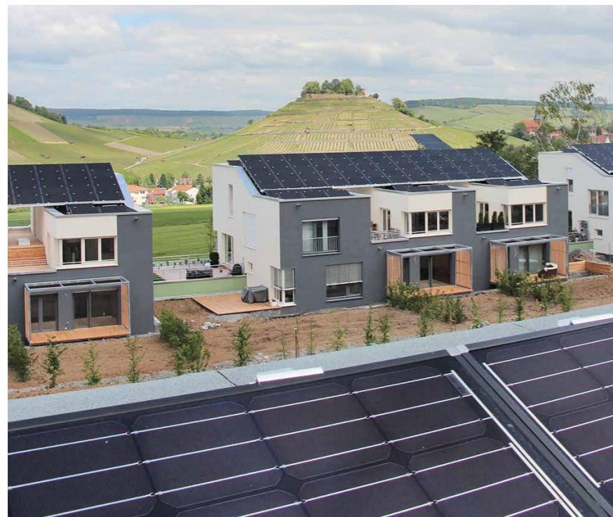
Maximaler Eigenverbrauch in einer Wohnsiedlung: 145 kW PV-Leistung für elektrische sowie thermische Speicherung.
