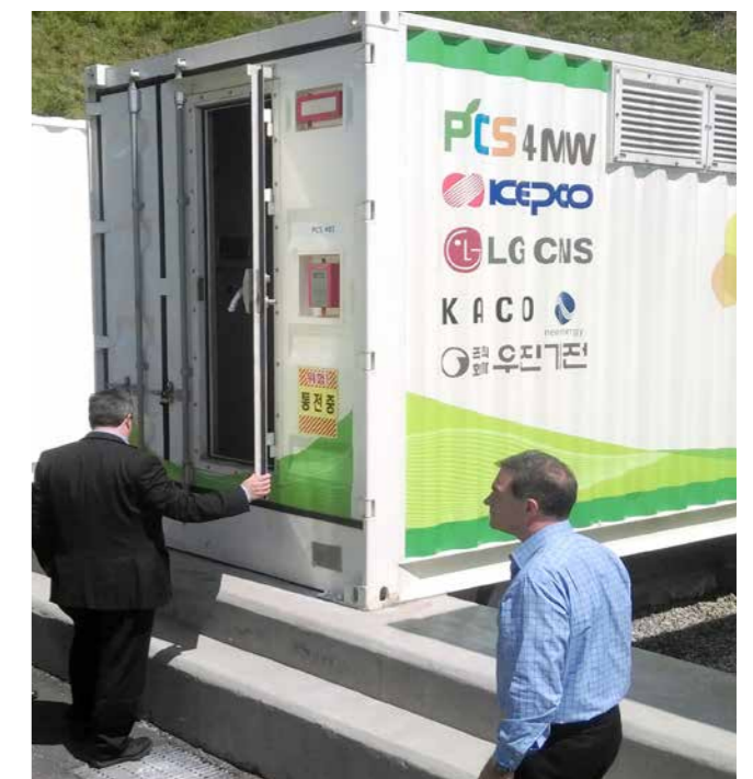
4-MW-Container des „Power Conditioning System“ (PCS), in dem sich der blueplanet gridsave 1000 TL3 befindet.
