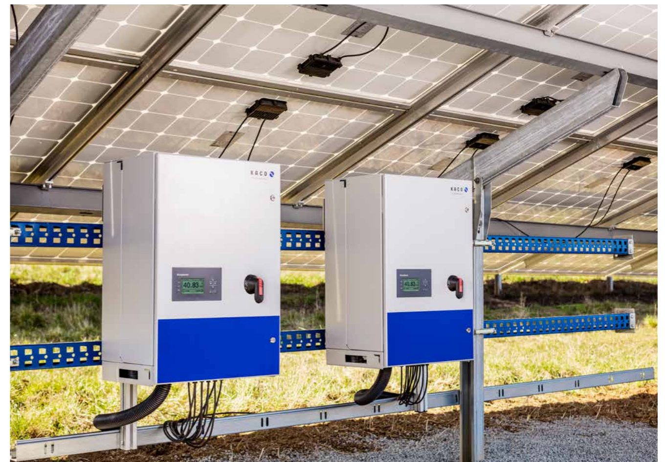
Beispiel eines dezentral ausgelegten Solarkraftwerks mit dem blueplanet 50.0 TL3.
