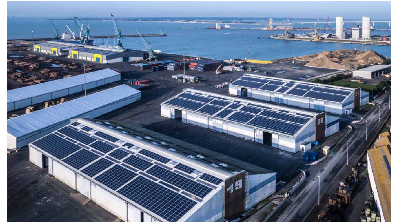
Frankreich, Port de la Rochelle, 250 kWp, Powador 60.0 TL3.
