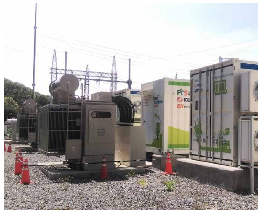
Ort des Projektes: Das Umspannwerk von Yong-In, einer Millionenstadt in der Nähe von Seoul.
