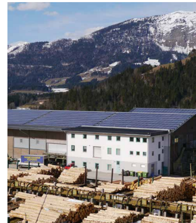
Österreich, Salzburg, 500 kWp, Powador 18.0 TL3.
