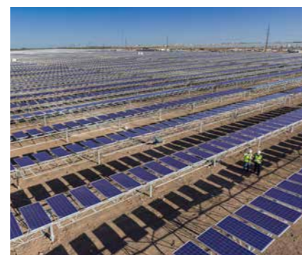
Das weltweit größte kommunale PV-Kraftwerk: Die Stadtwerke von San Antonio, Texas, bauen 400 MW Solarkraft mit der IPS 1.1 und IPS 2.0.
