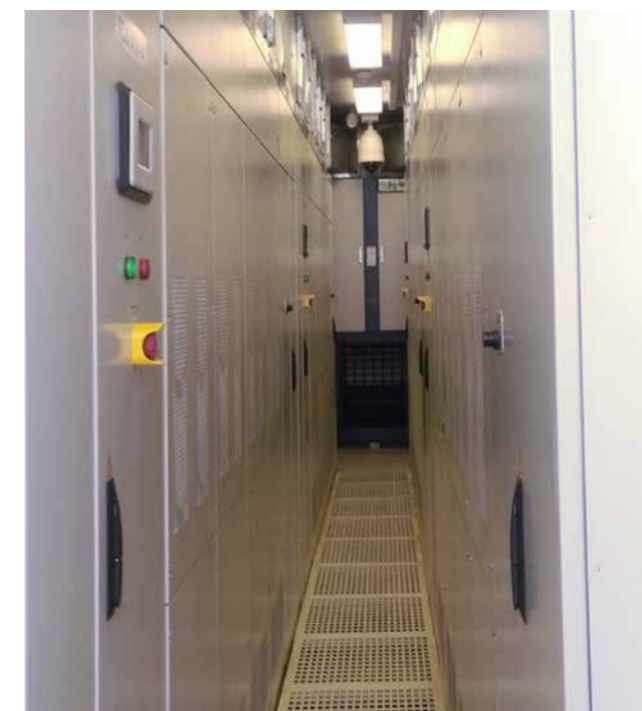
Der blueplanet gridsave 1000 TL3 ist so konzipiert, dass er sich trotz der Enge gut warten und bedienen lässt.
