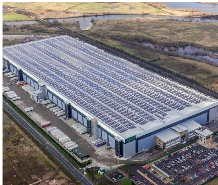
Die größte Dachanlage des Vereinigten Königreichs: 6,1 MW in Castle Donington.
