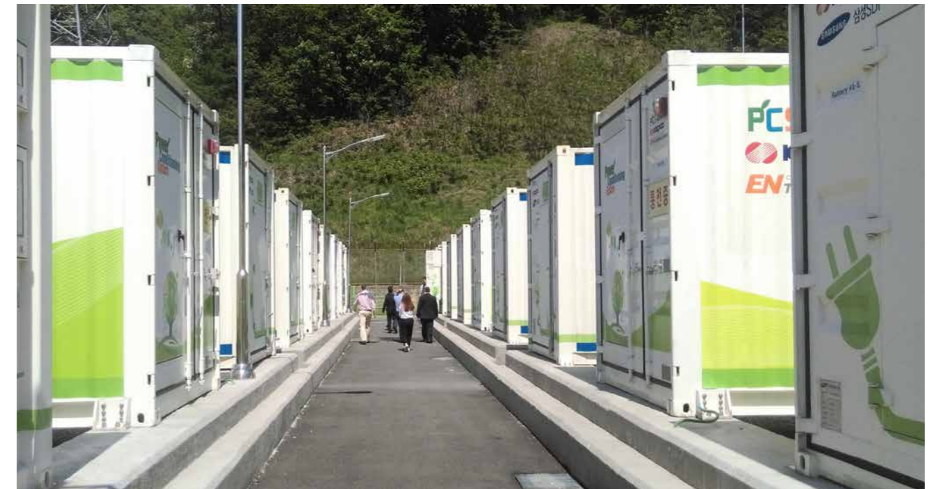
Am Ende der Gasse stehen die vier Container mit den Batteriewechselrichtern und Speichern.
