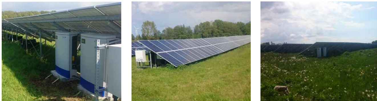
Wie für einander geschaffen: Das 3,6 MW PV-Kraftwerk nach dem Repowering mit KACO new energy Wechselrichtern.
