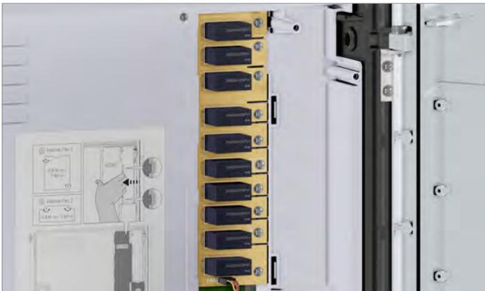
Fig. 4.12 : Vue des limiteurs de surtension DC lorsque le couvercle est retiré
