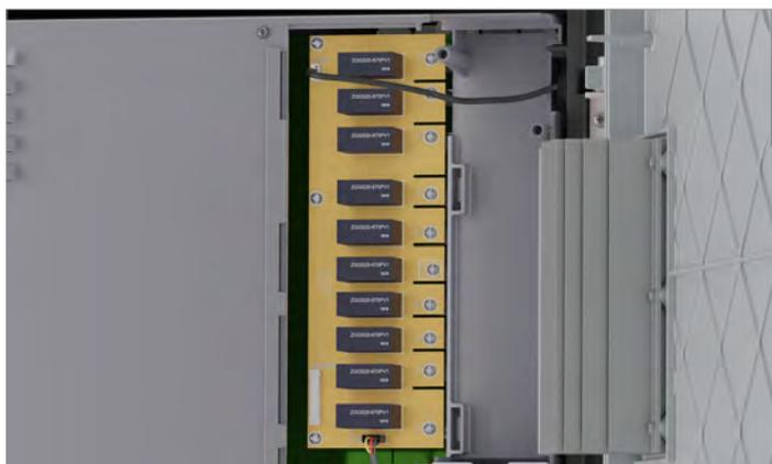
Abb. 4.11: Ansicht der DC-Überspannungsableiter bei entfernter Abdeckung
