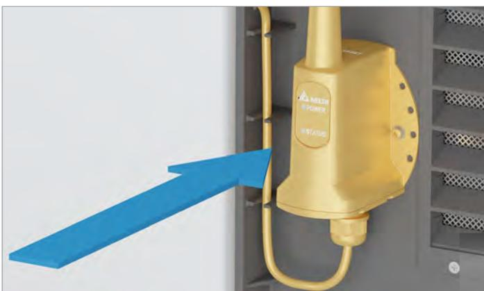
4. Das Wi-Fi-Modul abschrauben und entfernen.
