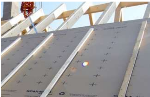
Abbildung 1: Regensicheres Unterdach (nach ZVDH)
