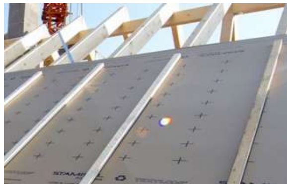
Abbildung 2: Regensicheres Unterdach (nach ZVDH)
